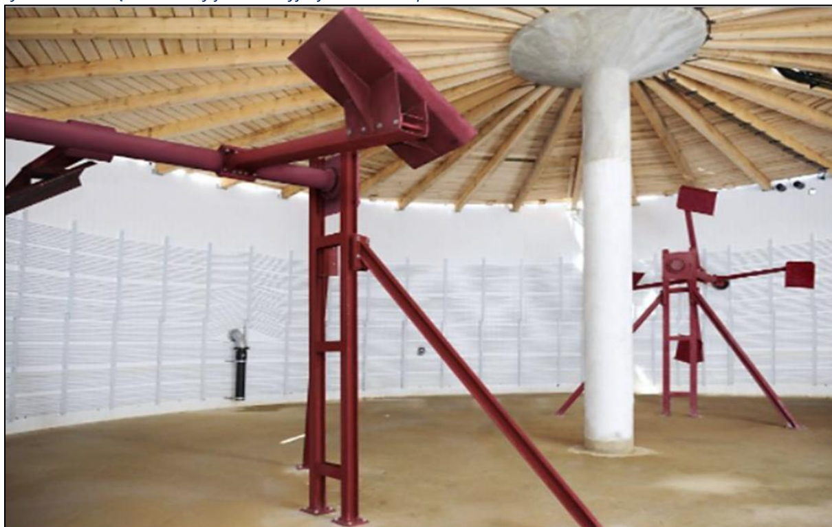
Rysunek 18. Wnętrze komory fermentacyjnej – mieszadło poziome.
