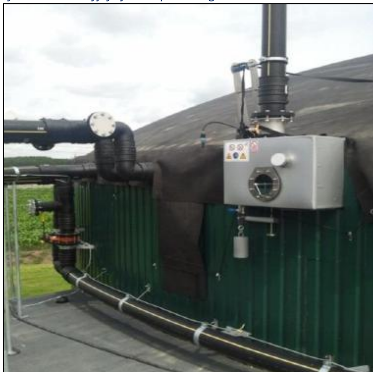
Rysunek 20. Awaryjny system upustu biogazu.
